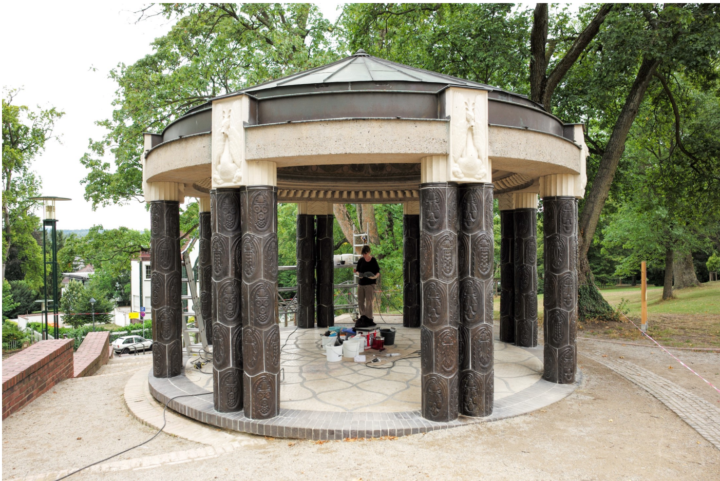
Der Schwanentempel mit sanierten Fugen zwischen den Kacheln und gereinigten Schwänen
